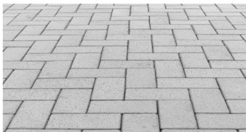
Após a execução da camada granular de pó de brita ou areia média que tem por função acomodar as peças de concreto proporcionando o nivelamento deverá ser executado o assentamento dos paver de concreto para não deixar o local desprotegido evitando a interferência de terceiros
