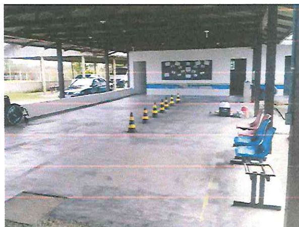
Foto 02: Área externa coberta
