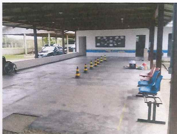
Foto 02: Área externa coberta
