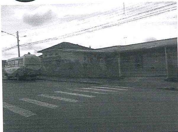
Imagem 01: Fachada da instituição
