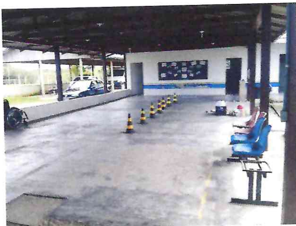
Foto 02: Área externa coberta
