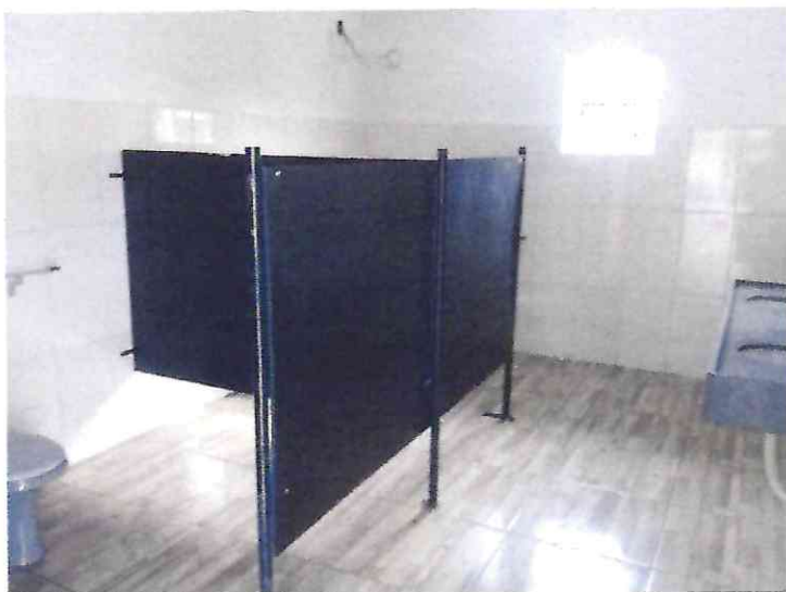
Foto 13: Banheiro feminino adaptado
